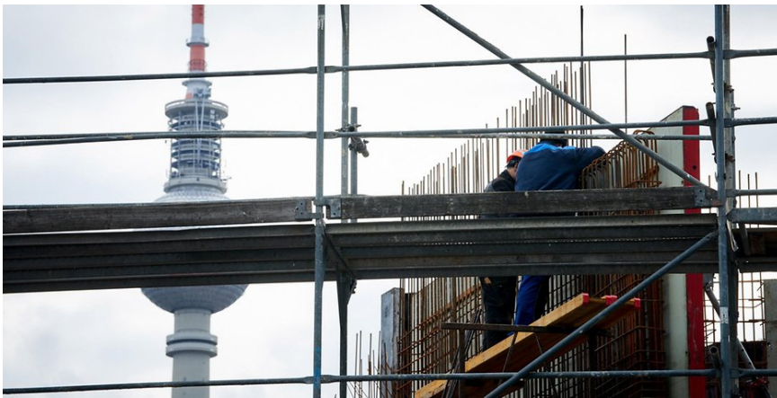
Bauarbeiter arbeiten an einem Wohnhaus. Foto: dpa/Annette Riedl
